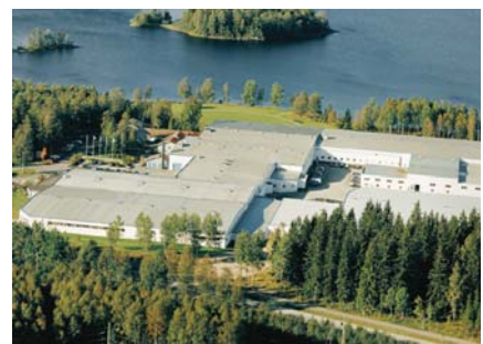
Systemair - г.Скинскаттеберг, Швеция
